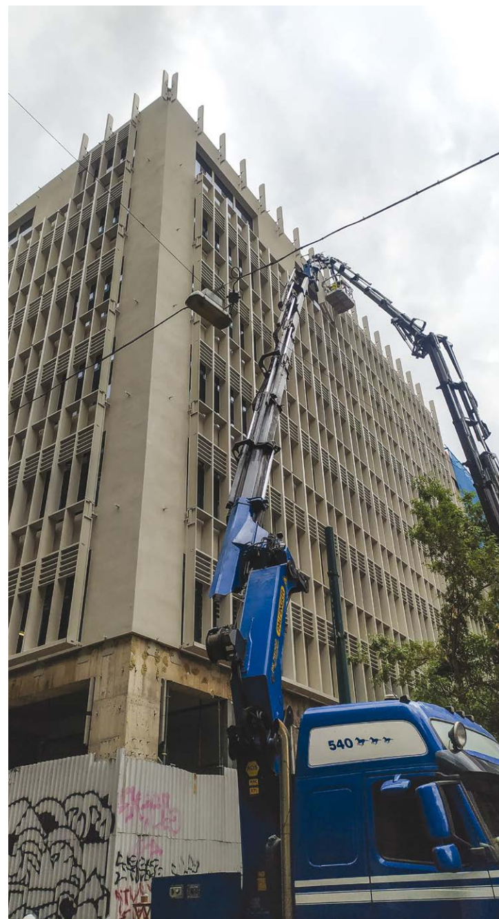
Όλα τα μέρη των πλαισίων συναρμολογήθηκαν στο εργοστάσιο και τοποθετήθηκαν στο εργοτάξιο σε έτοιμες μονάδες.
