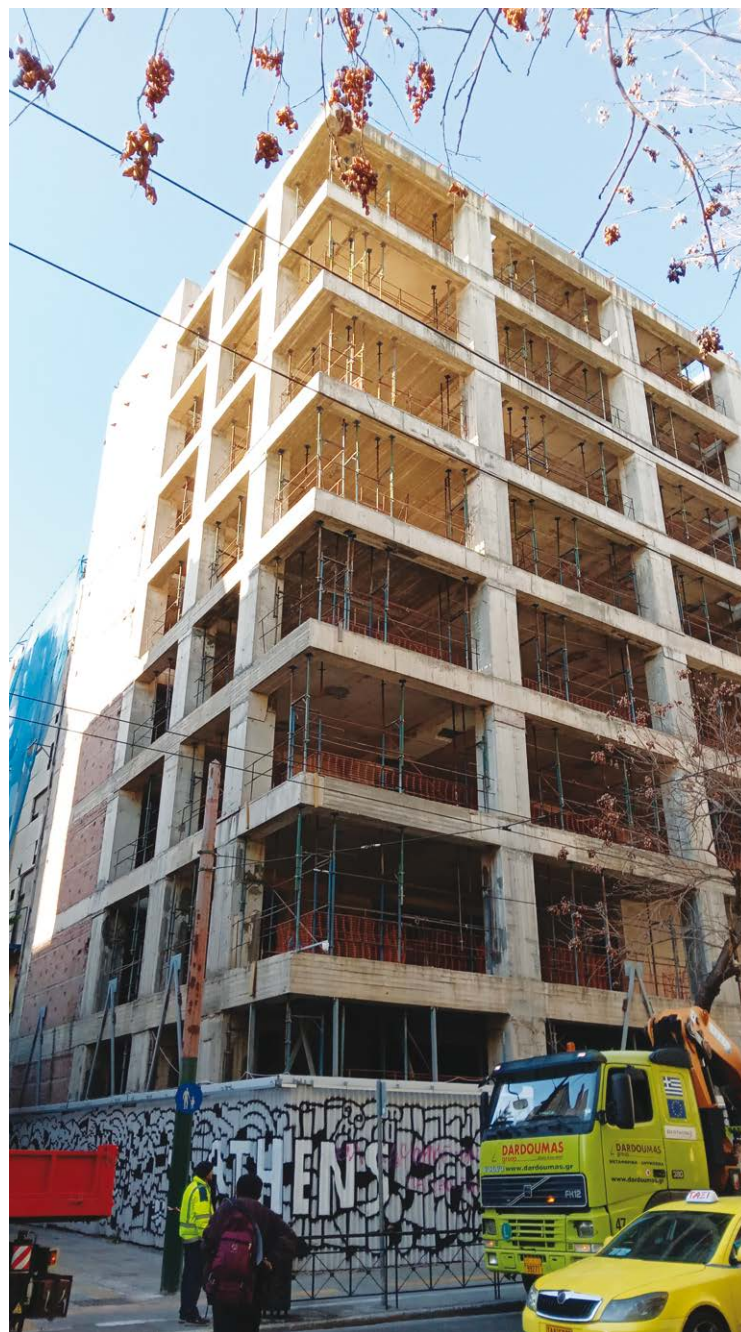
Το κτίριο πριν από τις εργασίες ανακατασκευής.
