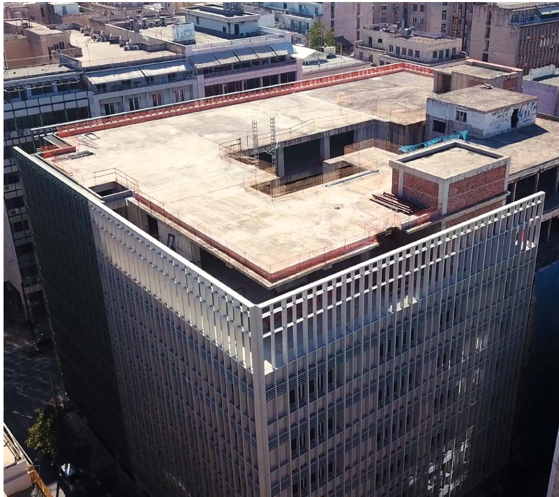
Η πίσω όψη του κτιρίου. Η βιωσιμότητα παίζει κάρδιο ρόλο στην αρχιτεκτονική του κτιρίου. "Πράσινες" οροφές, συστήματα εξοικονόμησης ενέργειας και περιβαλλοντικές πρακτικές συνθέτουν ένα κτίριο, που σέβεται το περιβάλλον.
