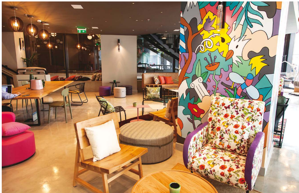
Εφαρμογή διακοσμτικού πατητού τσιμεντοκονιάματος με τσιμεντοειδές σύστημα δύο συστατικών σε δάπεδο και κατακόρυφες επιφάνειες στο lounge bar.
