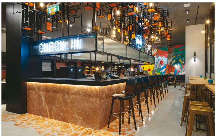
Ολοκλήρωση της αρχιτεκτονικής μεταλλικής κατασκευής οροφής και του χώρου bar. ©Νίκος Δανιηλίδης.
